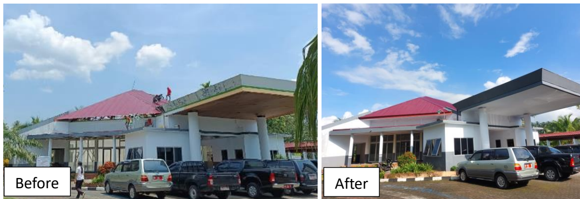
Gambar 62. Penggantian atap bangunan
