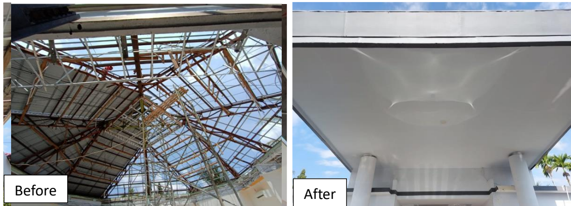
Gambar 61. Pembongkaran atap, plafon dan rangka atap
