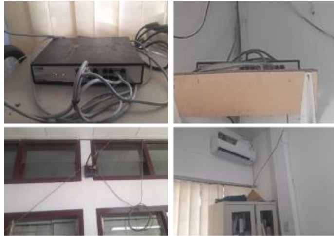
Gambar 24. Perbaikan Switch pada ruangan
