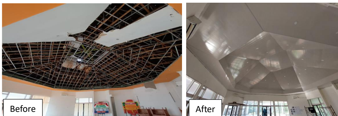
Gambar 60. Kondisi Plafon Auditorium Cocos setelah renovasi
