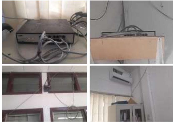
Gambar 21. Perbaikan Switch pada ruangan
