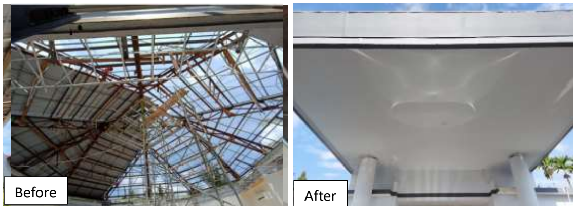
Gambar 42. Pembongkaran atap, plafon dan rangka atap
