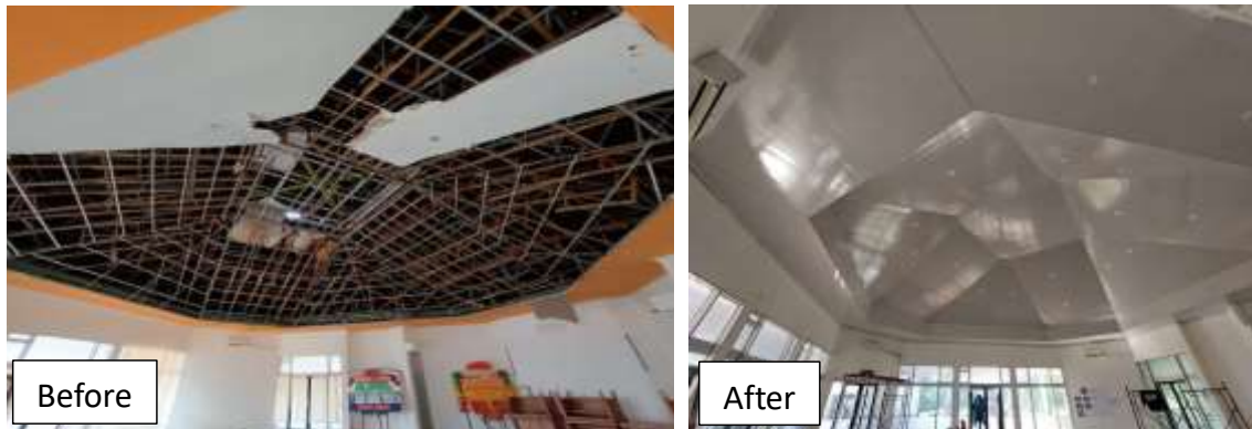
Gambar 41. Kondisi Plafon Auditorium Cocos setelah renovasi
