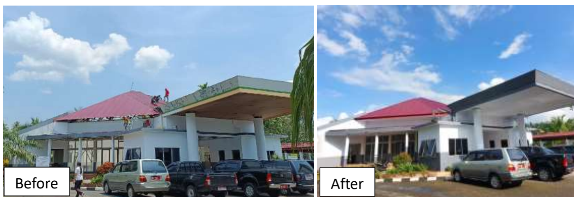
Gambar 43. Penggantian atap bangunan
